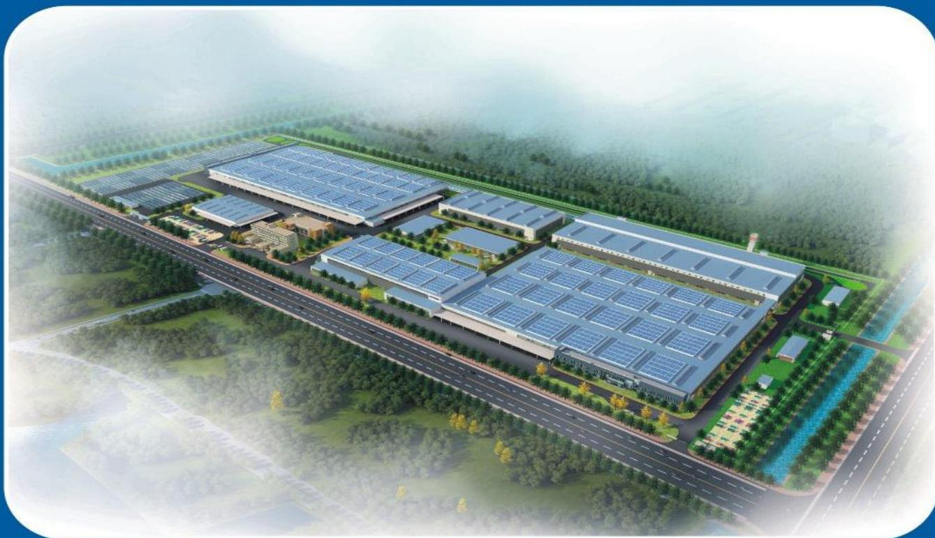
杭州吉利隶属于浙江吉利控股集团，成立于2016年5月，注册资本2亿元人民币，项目用地位于杭州大江东产业集聚区丰悦路1555号。项目总规划用地面积约54.36万平方米（815亩），其中在建项目占地面积约40.99万平方米（615亩），待征待建项目占地面积约13.37万平方米（200亩）。项目规划建设年产10万辆乘用车，总投资约80亿元，规划总建筑面积约35.60万平方米，建有整车冲压、焊装、涂装、总装四大工艺先进生产线以及与之配套的小涂装、动力站房、试车跑道、停车场、管理办公中心等辅助功能设施，购置世界先进水平的数控伺服压力机、起重机、珩磨机、三坐标测量机和焊接机器人、喷漆机器人等生产和检测先进设备。
